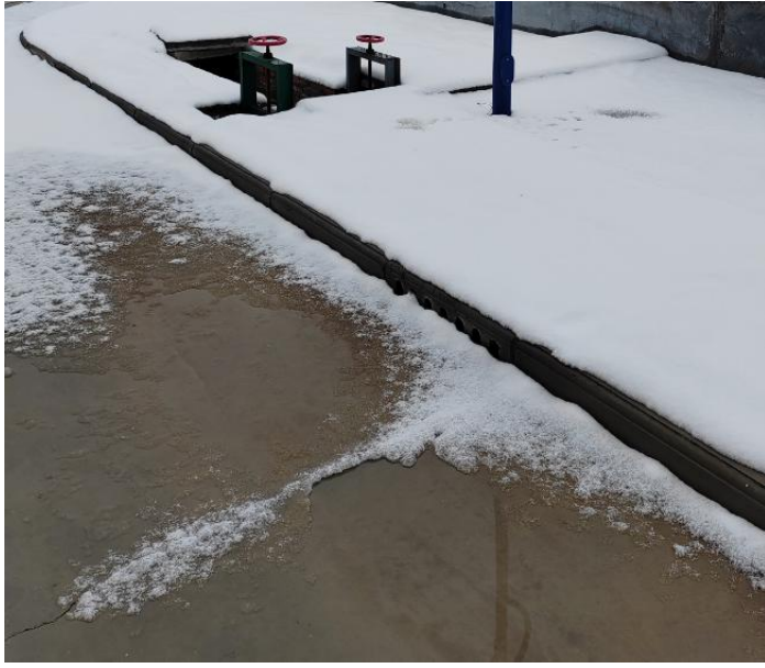
道路旁立篦式雨水口
